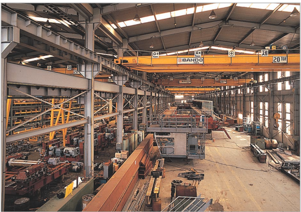
:: 철구조물 생산공장 CRANE ::
