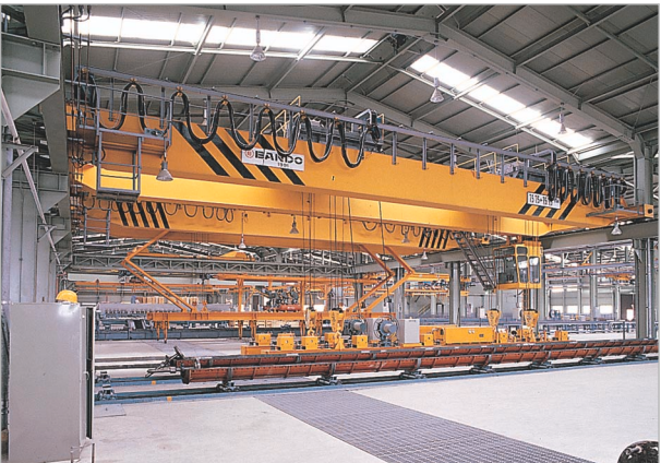
:: CONCRETE PILE 제조공장 CRANE ::
